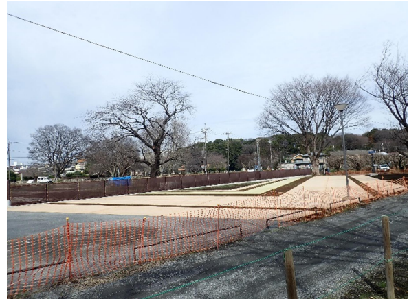
中枢部区画施設平面表示（南東から）
